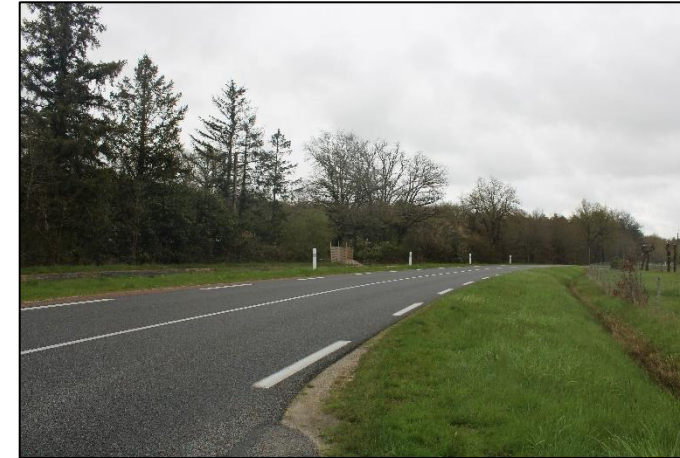
Route départementale RD921
