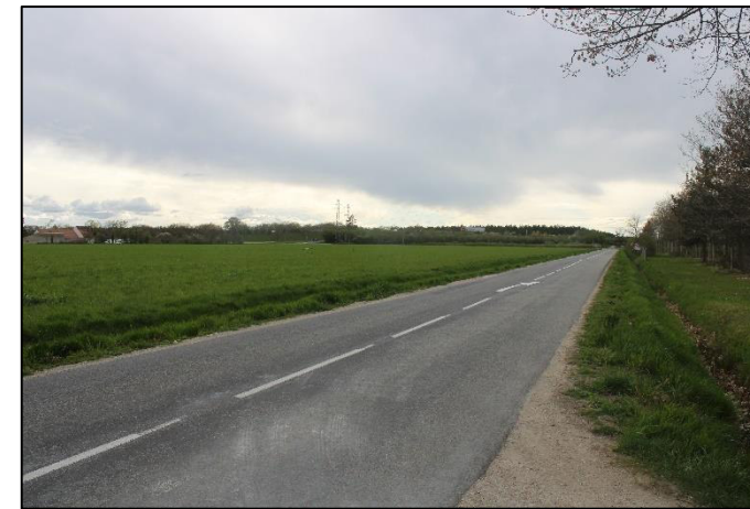
Route départementale RD7
