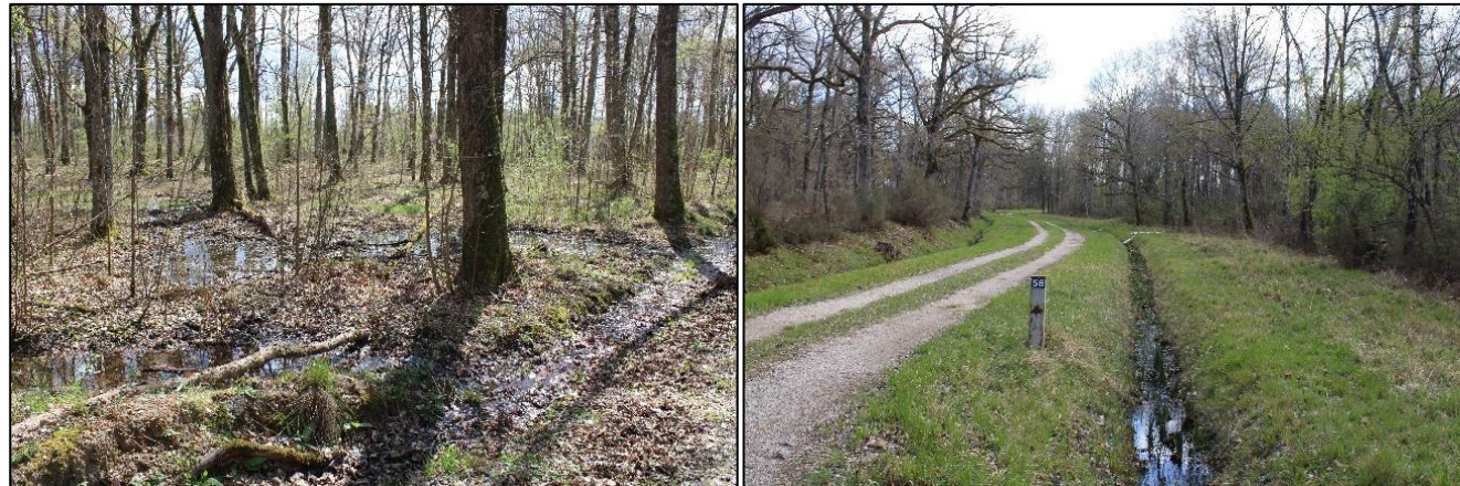
Figure 247 : Fossés et stagnation d'eau au droit de l'aire d'étude immédiate - source : SOLER IDE, avril 2023
