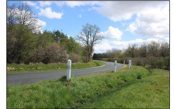
Route départementale RD168
