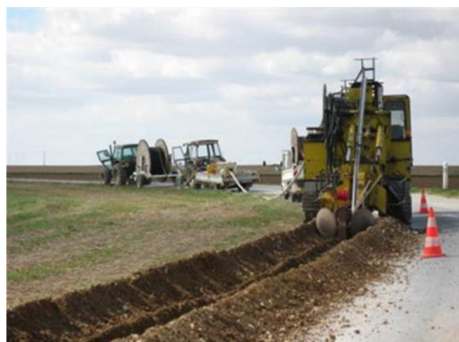
Figure 52 : Réalisation de tranchées du raccordement externe dans l'emprise des voies existantes - source : EDF Renouvelables
