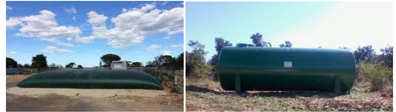
Figure 40 : Exemple d'une citerne souple et d'une citerne en dur (Source : EDF Renouvelables)
