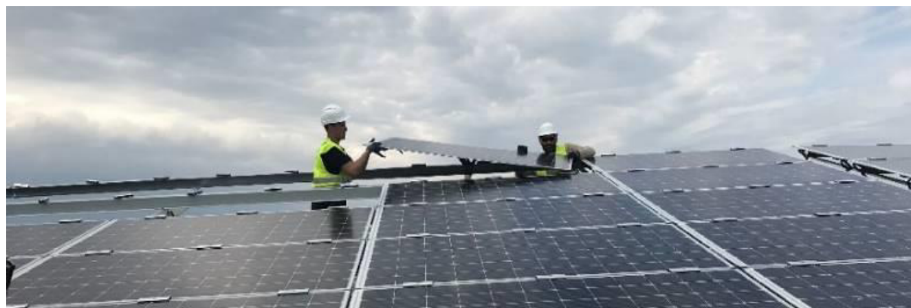
Figure 49 : Pose des modules - source : EDF Renouvelables
