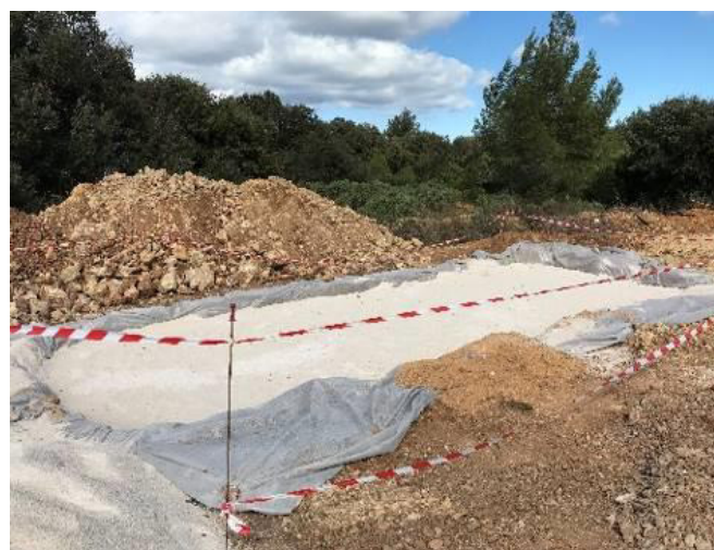
Figure 51 : Fouille préparée pour la pose d'un poste de conversion/transformation - source : EDF Renouvelables
