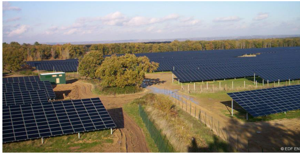
Figure 23 : Fauche différenciée sur la centrale solaire de Narbonne (11) (photo du haut) et corridor écologique préservé en fin de chantier au sein de la centrale de Bouloc (31) (photo du bas) - source : EDF Renouvelables
