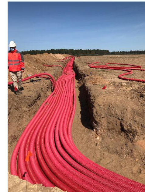
Figure 50 : Exemple de réalisation de tranchées du raccordement interne - source : EDF Renouvelables
