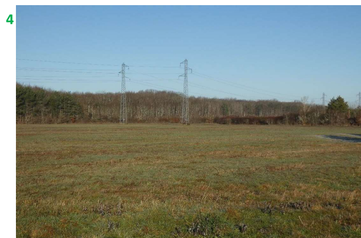
Lignes haute tension sur le site
