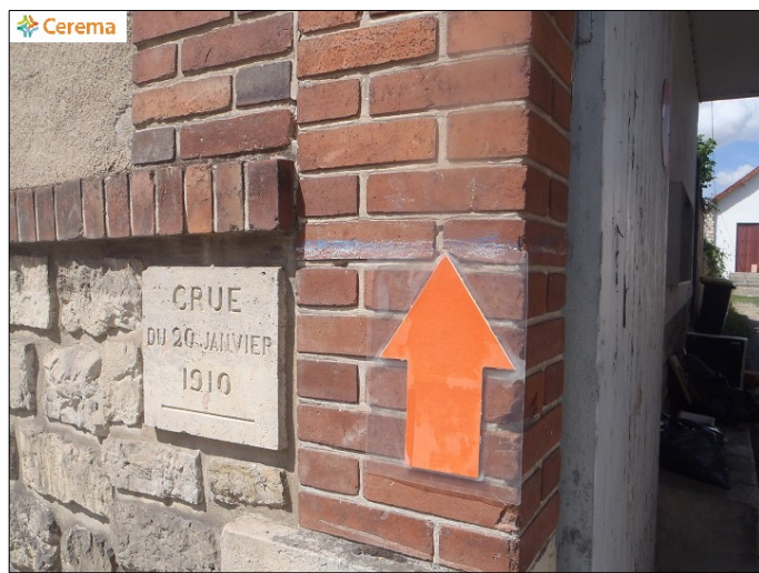
Illustration 8 : repère de la crue de 1910 posé par un riverain et marque peinte pour la crue de 2016
