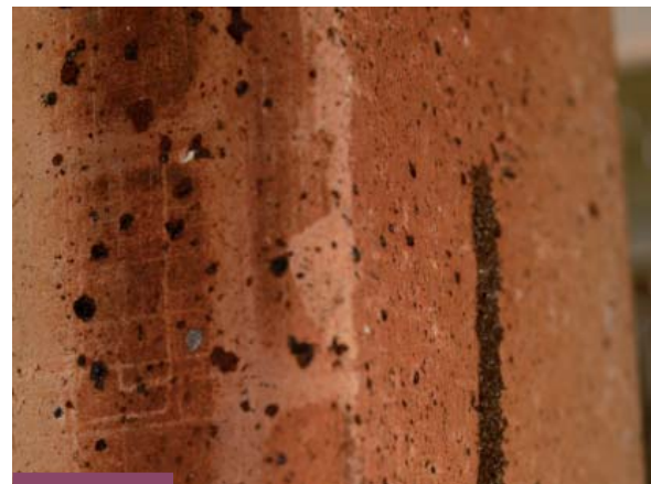
Construction d'une galerie tunnel (cordonnet) sur brique
