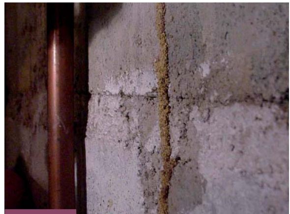
Construction d'une galerie tunnel (cordonnet) sur maçonnerie
