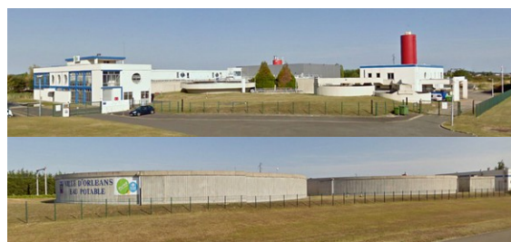
Usine de traitement d'eau potable de l'agglomération d'Orléans
