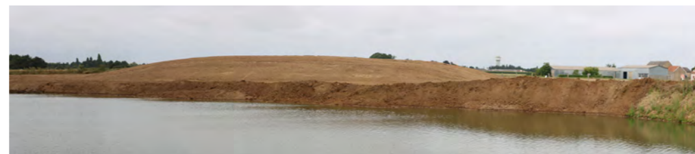
Modification de la topographie : présence de fronts d'extraction, de matériaux temporairement stockés et d'une surface en eau sur la carrière actuelle
