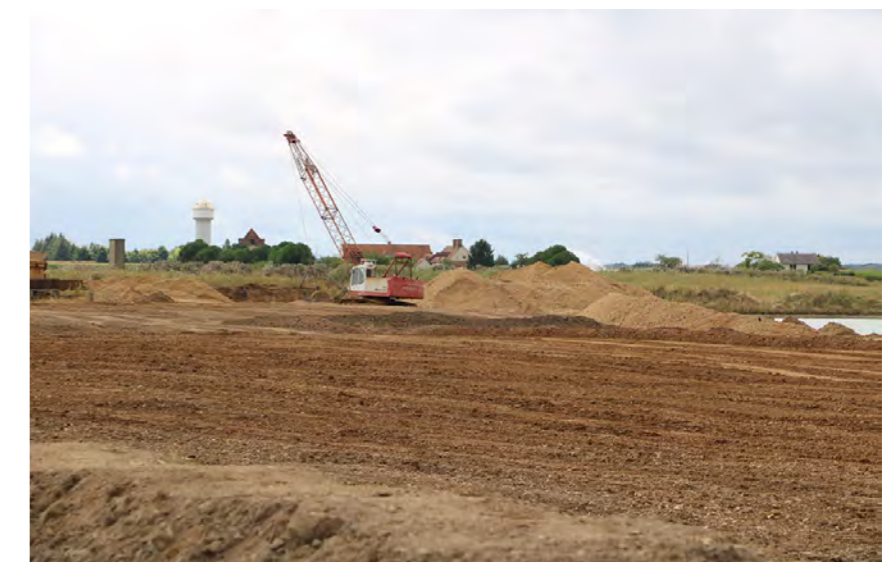
Contraste d'ambiance : ambiance de chantier sur la carrière actuelle
