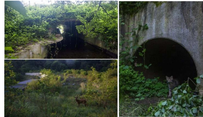
Figure 115 : Ouvrages de traversée de la faune (Source : SOLARVIA)
