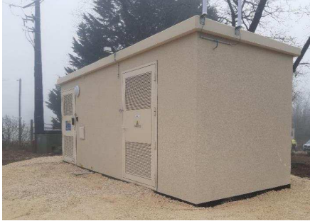
Figure 137 : Exemple de PDL (Source : SOLARVIA)
