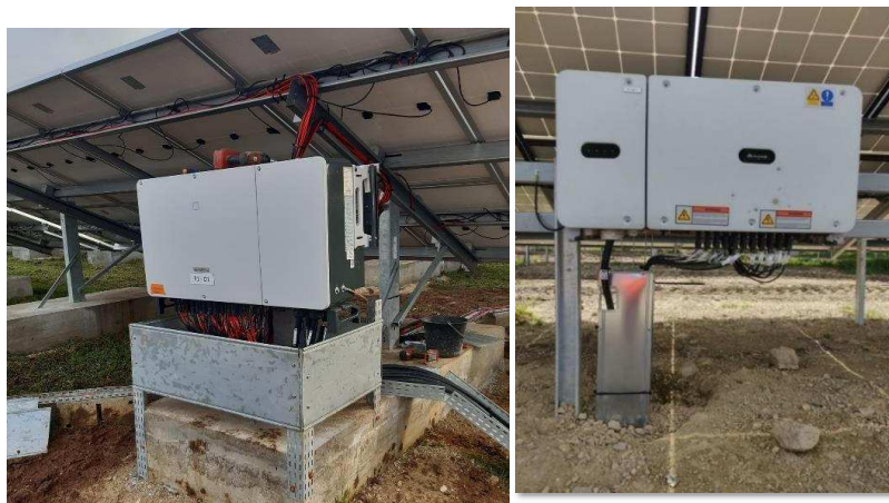
Figure 142 : Exemple de raccordement d'un onduleur aux modules (Source : SOLARVIA)
