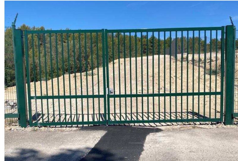
Figure 139 : Exemple de portail (Source : SOLARVIA)
