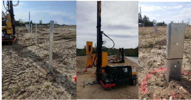
Figure 133 : Exemple d'installation de pieux battus (Source: SOLARVIA)
