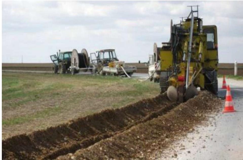
Figure 25 : Illustration des travaux de raccordement réalisés par ENEDIS (source : EDF Renouvelables)
