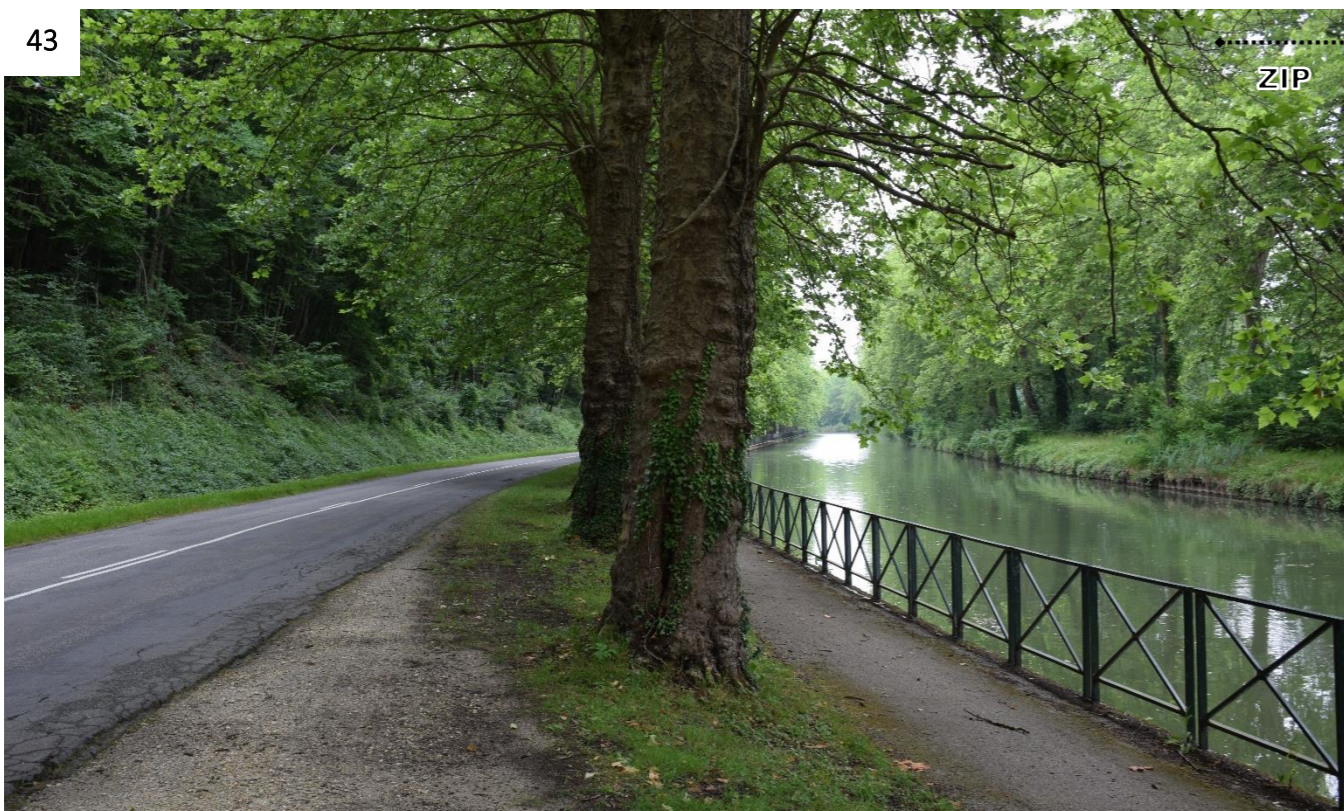
Figure 78 : Depuis la D32 au nord de Nargis (© ATER Environnement, 2022)
