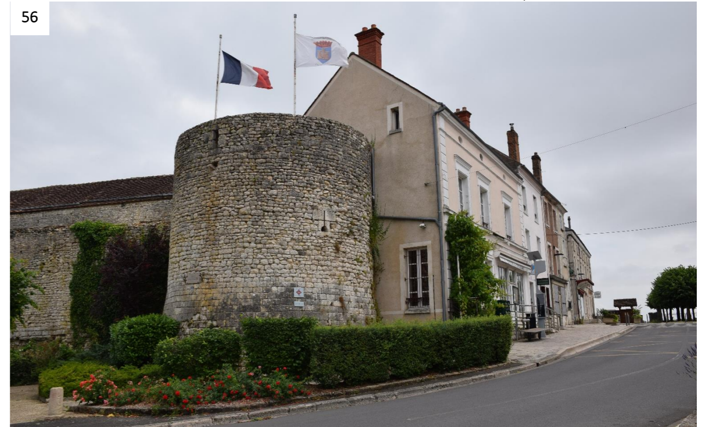
Figure 94 : Ancienne Porte Madeleine (@ ATER Environnement, 2022)
