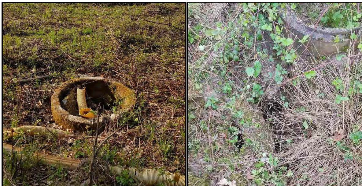
Figure 12 : Illustrations photographiques de drains à la surface et de regards présents sur le site d'étude
