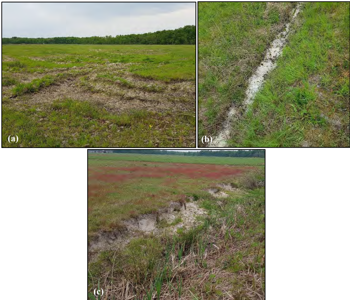
Figure 14 : Illustrations photographiques de stagnation des eaux et d'érosion (a : Ornières de tracteur ; b : Traces de stagnation dans un fossé ; c : Erosion de fossé)
