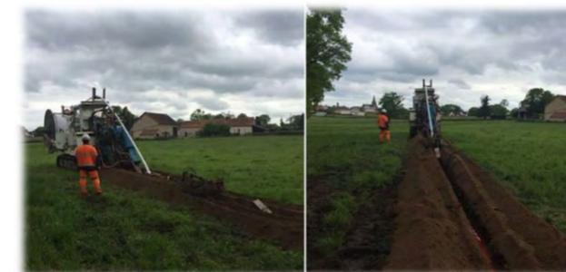
Figure 94 Exemple de chantier d'enfouissement d'un réseau électrique en terres agricoles
