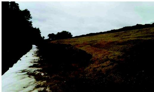
*Illustration 40: géotextile mis en place sur le filtre drainant - Sully-sur-Loire - 2017*
