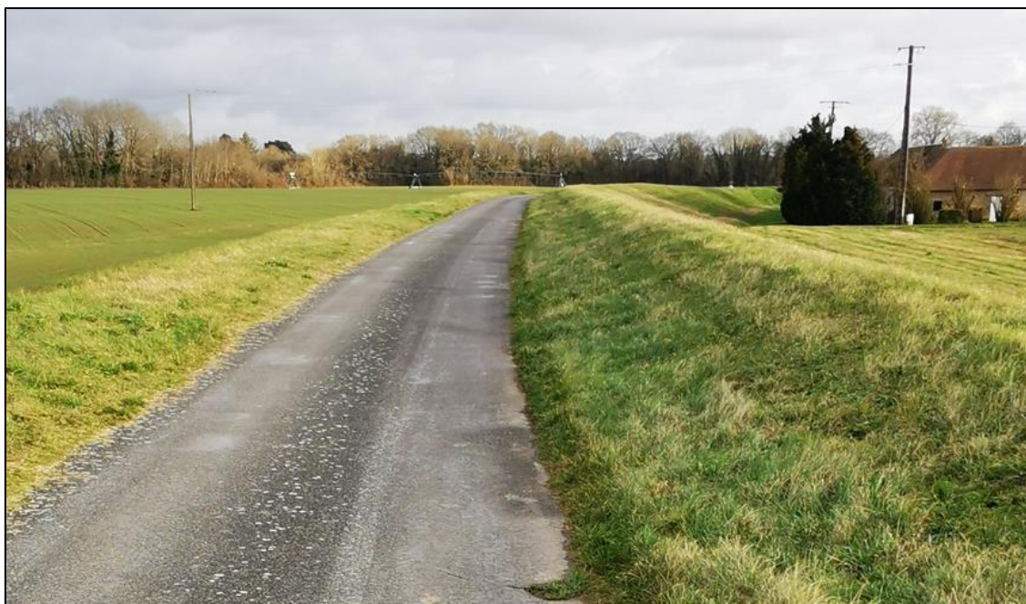
Figure 41 - Vue du système d'endiguement au niveau du secteur de Guilly - photo du 20/01/2022 (Source : Antea Group)
