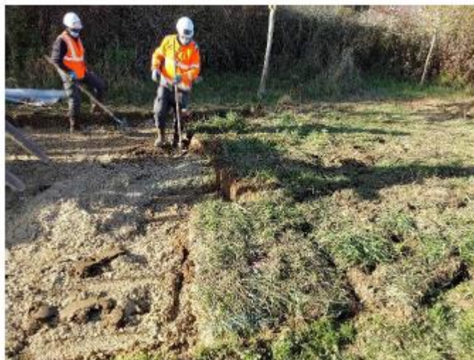
Figure 95 - Exemple de décapage par plaque (Source : INGEROP, 2021)
