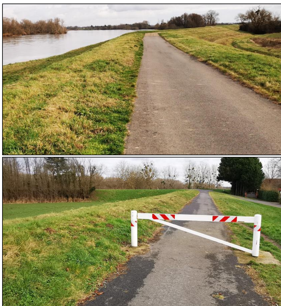
Figure 40 - Barrières et panneaux identifiés sur la levée au niveau de la commune de Sigloy - photo du 22/01/2022 (Source : Antea Group)
