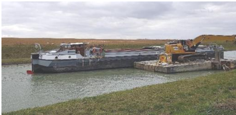
Figure 29 : Illustration d'un dragage mécanique d'une pelle sur ponton (source : VNF)
