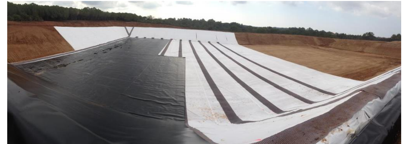
Installation d'une géomembrane dans un bassin de rétention d'eaux pluviales (Source : Afitex)
