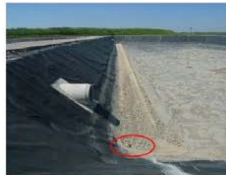
3 - Ouvrage de fuite en fond (cercle rouge) et canalisation 1000 mm au dessus
