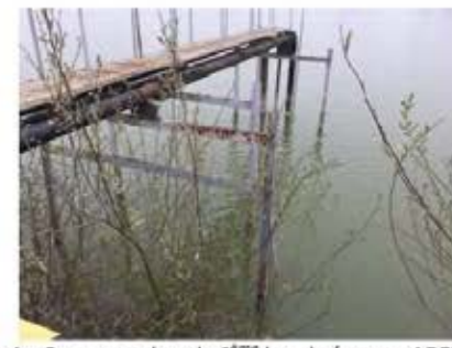
4 - Pompage dans le 3 ème bassin (source ADEV)
