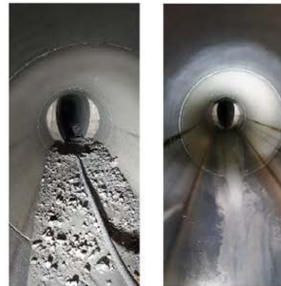
Photo 6- Photographies hydrocurage tronçon sous le taxiway
