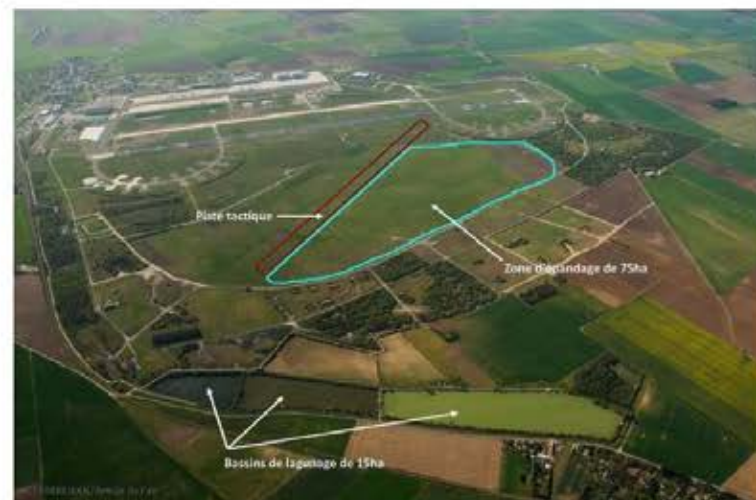
Figure 5- Zone d'épandage des lagunes
