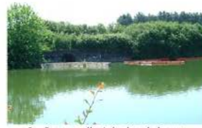
2 - Ouvrage d'entrée dans la lagune
