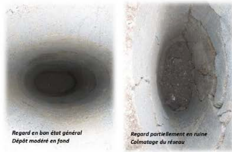
Photo 2- Photographies du T90 nord
