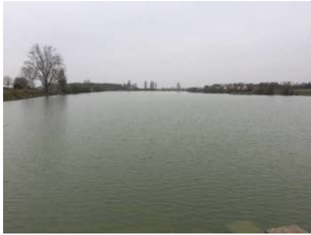
Photo 1 : Bassin 3 du système de lagunage
