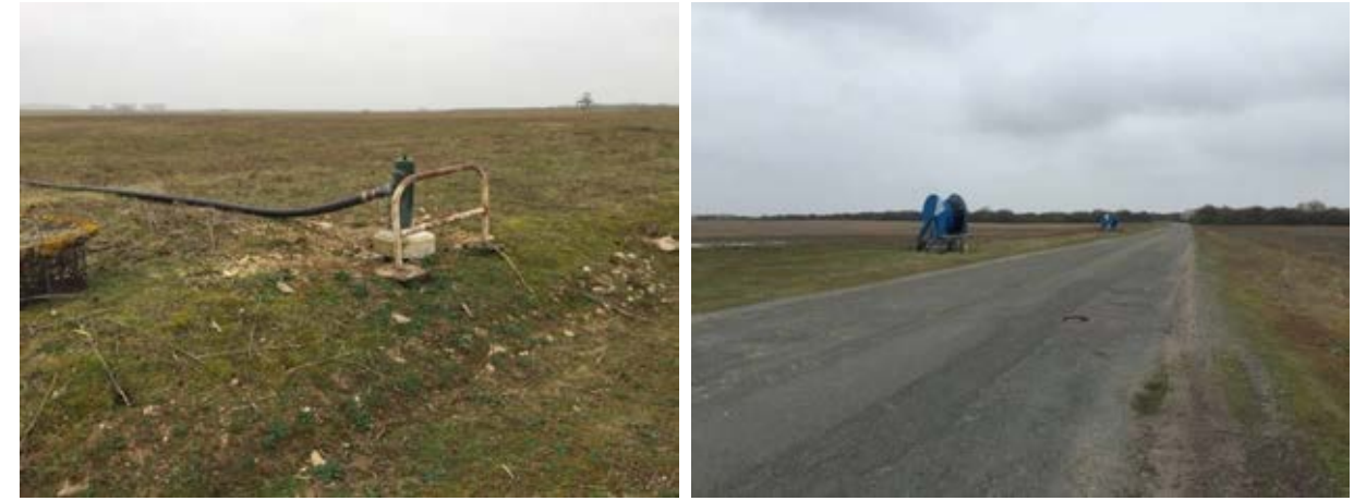
Photos 4 : Système d'épandage des eaux de la lagune
