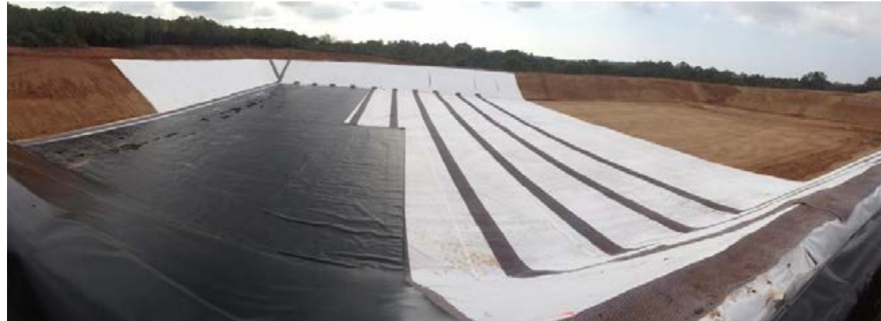
Illustration 1 : Installation d'une géomembrane dans un bassin de rétention d'eaux pluviales (Source : Afitex)
