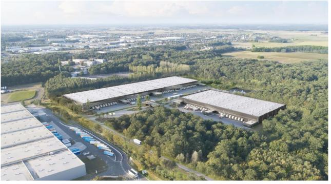
L'ensemble des cellules disposera d'une hauteur au faitage de 13,7 m et d'une hauteur à l'acrotère de 14 m.
