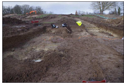
Vue générale du sondage 8 en cours de fouille
