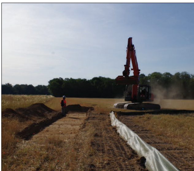
Barrières amphibiens installées sur l'emprise de fouille.
