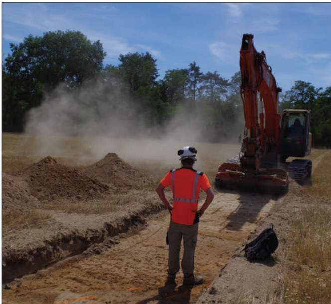
Vues du décapage.
