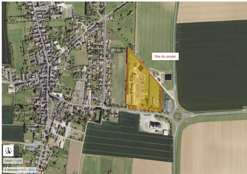
Figure 2 : Vue aérienne du site STCM
