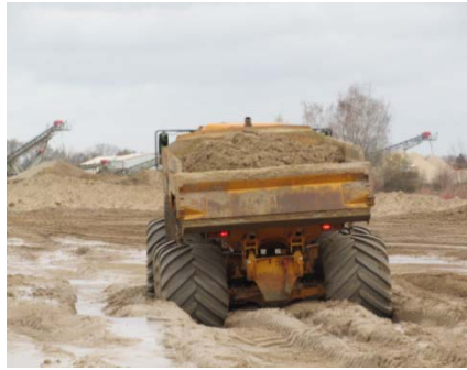
Enlèvement des engins (source : EQIOM Granulats hiver 2012 - 2013)
