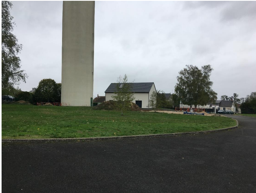
Photo 3 : Vue du périmètre immédiat (château d'eau, local de traitement et forage F3)
