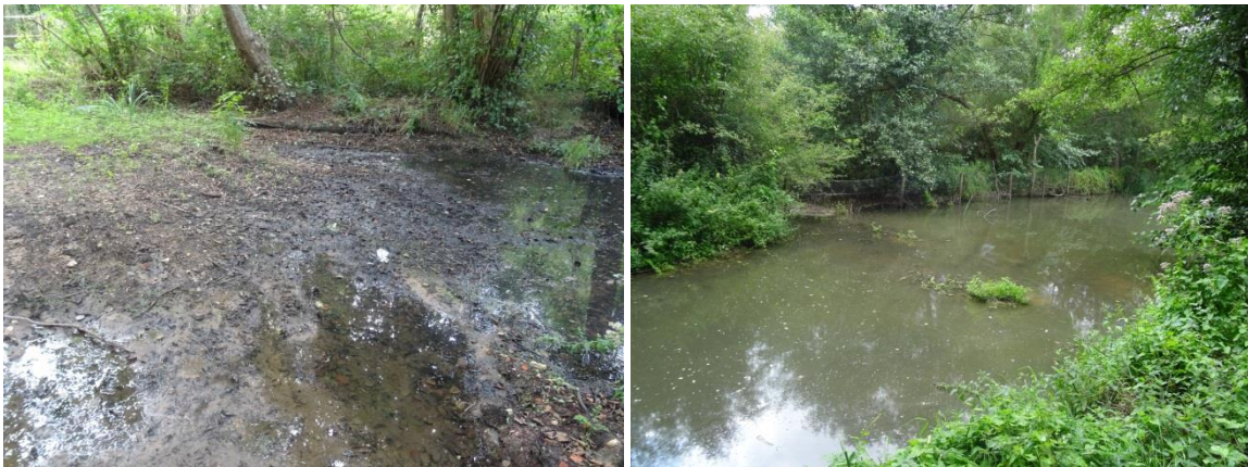
Figure 47 : Envasement sur la zone d'influence des étangs de Nogent-sur-Vernisson
