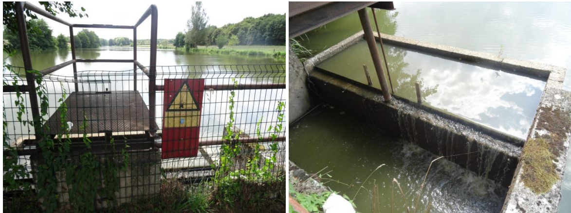
Figure 33 : Vues de l'ouvrage amont
