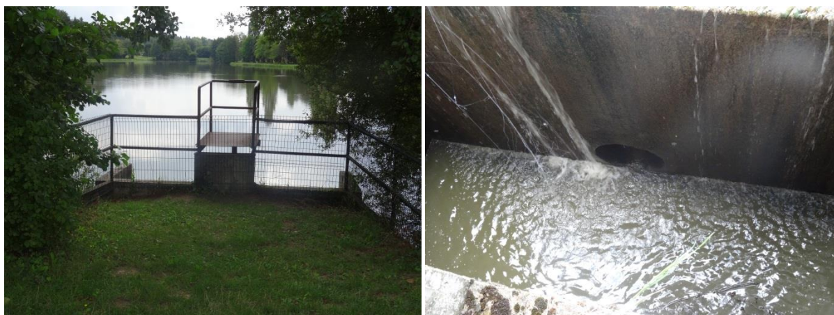
Figure 5 : Vues de l'ouvrage aval
