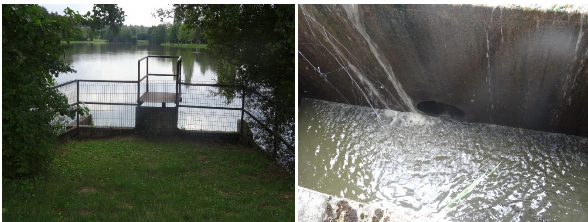
Figure 34 : Vues de l'ouvrage aval
