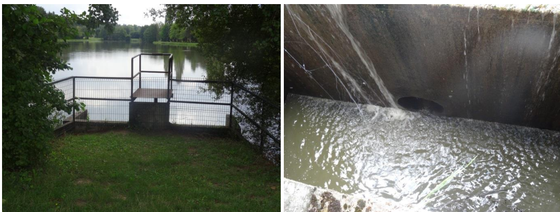
Figure 2 : Vues de l'ouvrage aval
