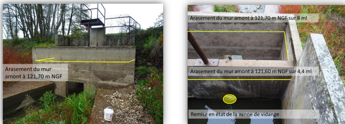
Figure 18 : Arasement des murs
