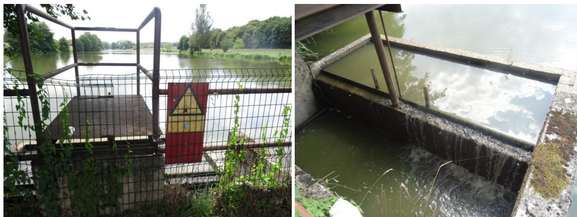
Figure 4 : Vues de l'ouvrage amont
