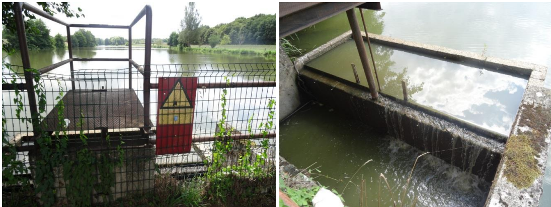
Figure 1 : Vues de l'ouvrage amont
