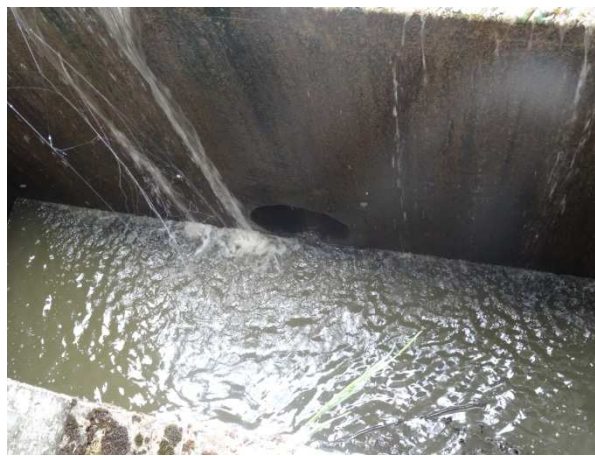
Vue aval de l'ouvrage
