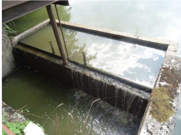
Vue amont de l'ouvrage
