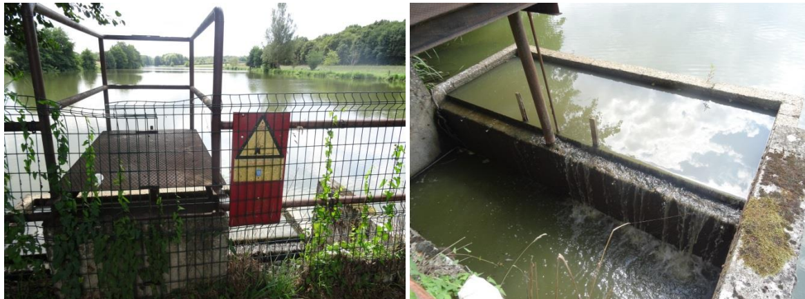
Figure 2 : Vues de l'ouvrage amont
