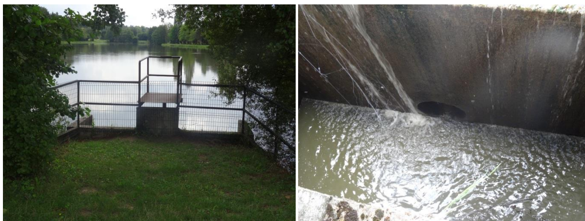
Figure 3 : Vues de l'ouvrage aval
