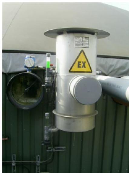
Exemple de soupape de sécurité.
