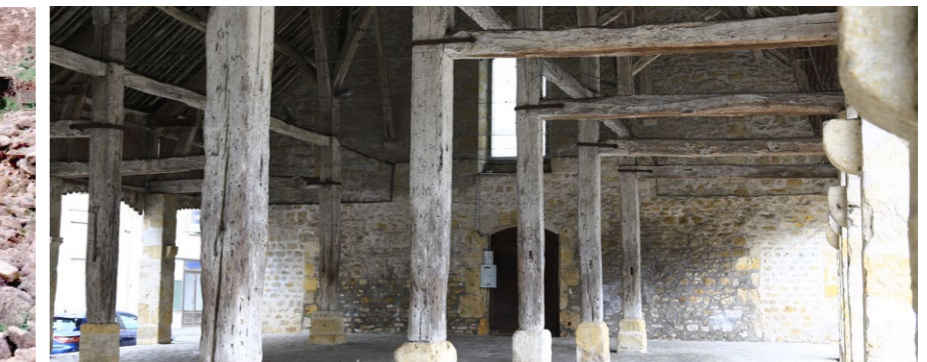
Photographie 58. Halle de Puisseaux
