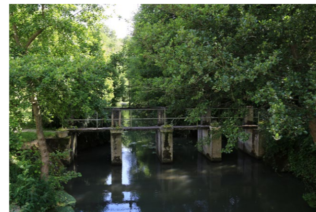
Photographie 70. Ouvrage sur la Rimarde à Yèvre-le-Chatel
