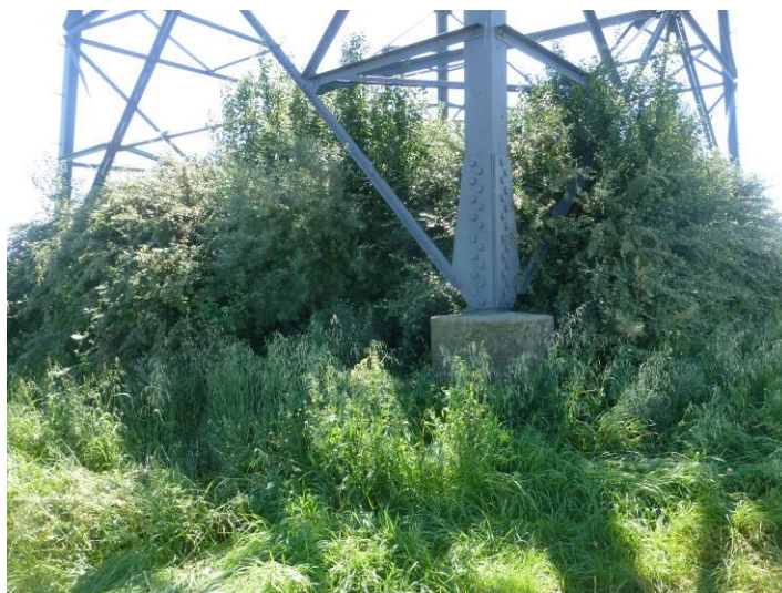
Photo 4 : Pylône et végétation arbustive
