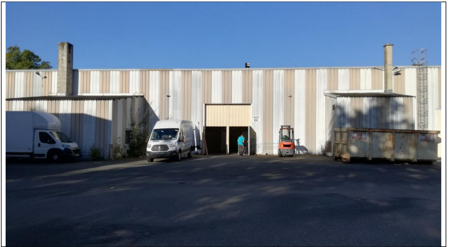
Chaudières gaz du Parc des Expositions
