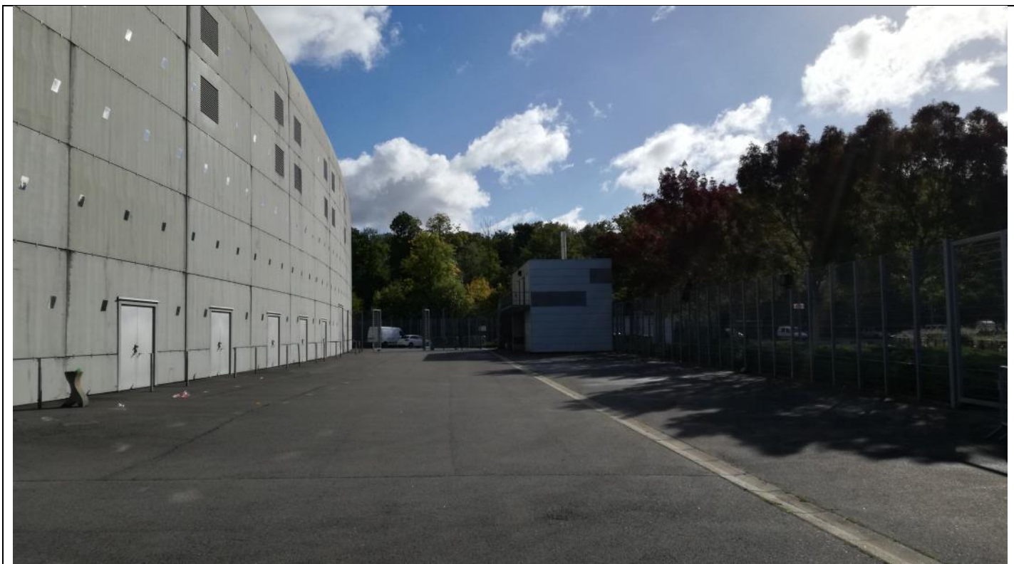
Locaux techniques du Zénith (chaudière et transformateur à l'étage)
