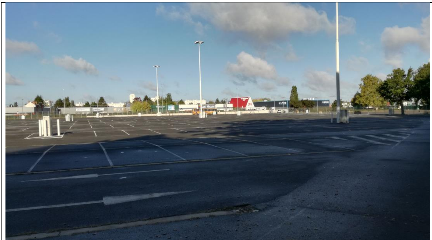
Parking du Parc des Expositions (avec grille réseaux EP)
