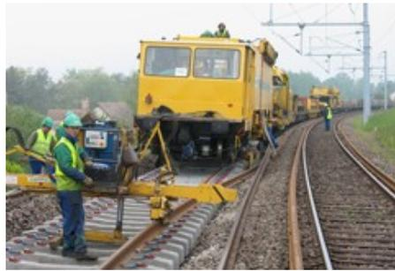
*Longs Rails soudés sur traverses béton*
